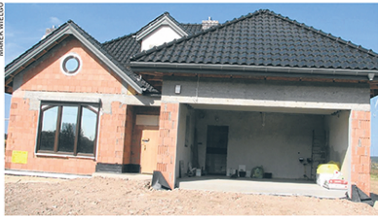
Dom Piotra Burczyńskiego, który przyznaje, że budowa kosztowałaby go o wiele mniej, gdyby zdecydował się na projekt domu pasywnego
